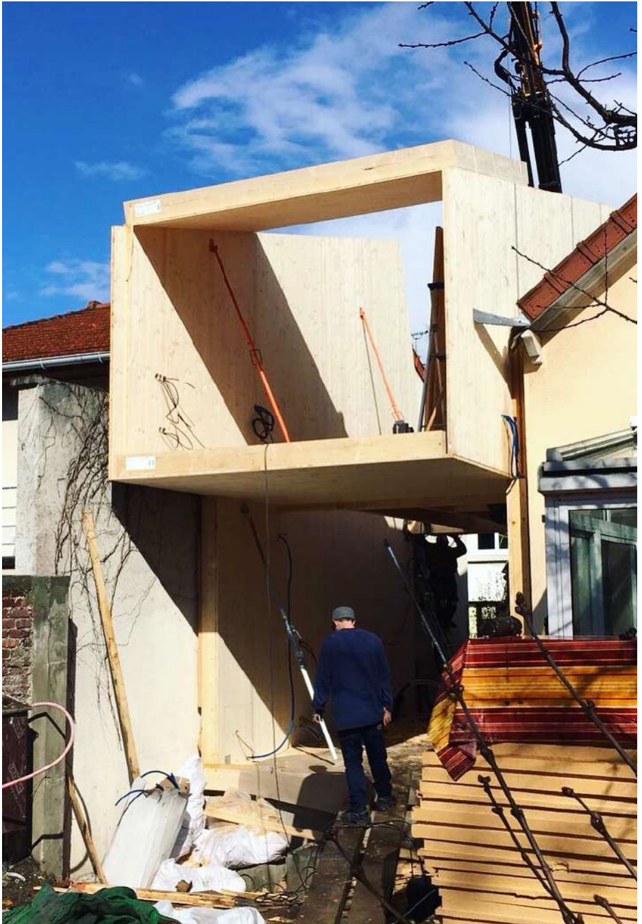
Chantier - Montage de l'ossature bois en CLT
