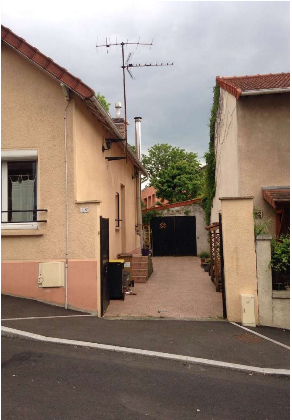
Gentilly (94) - Avant travaux
