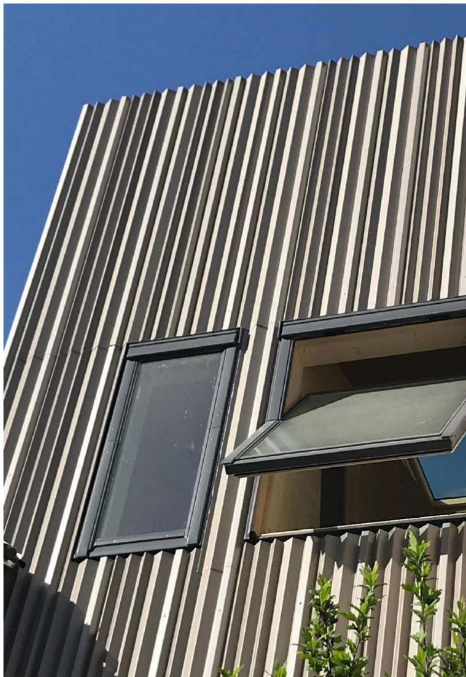
Détail - La tôle ondulée
