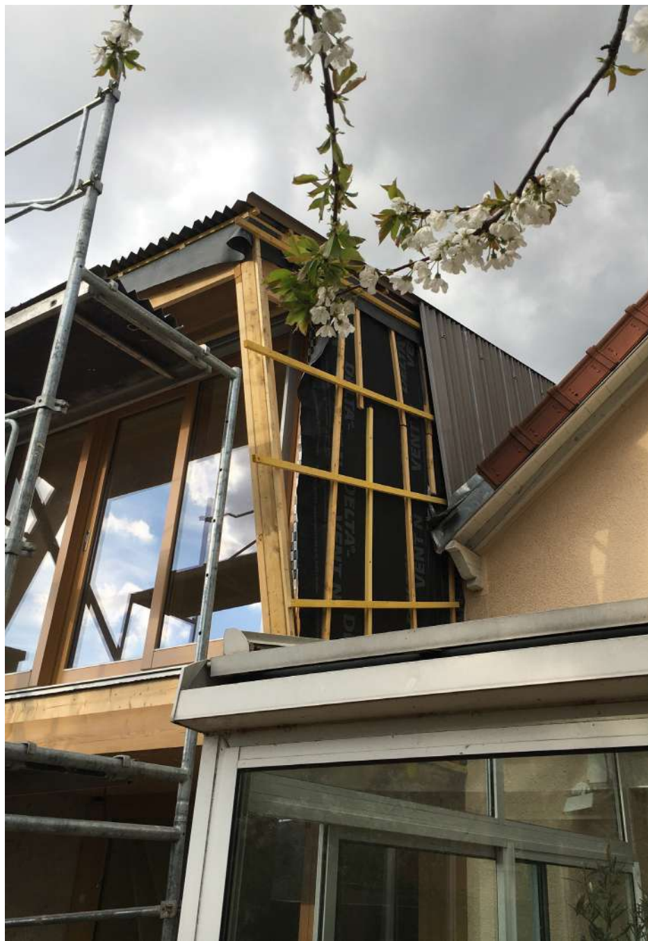
Chantier - Pose de la tôle pliée
