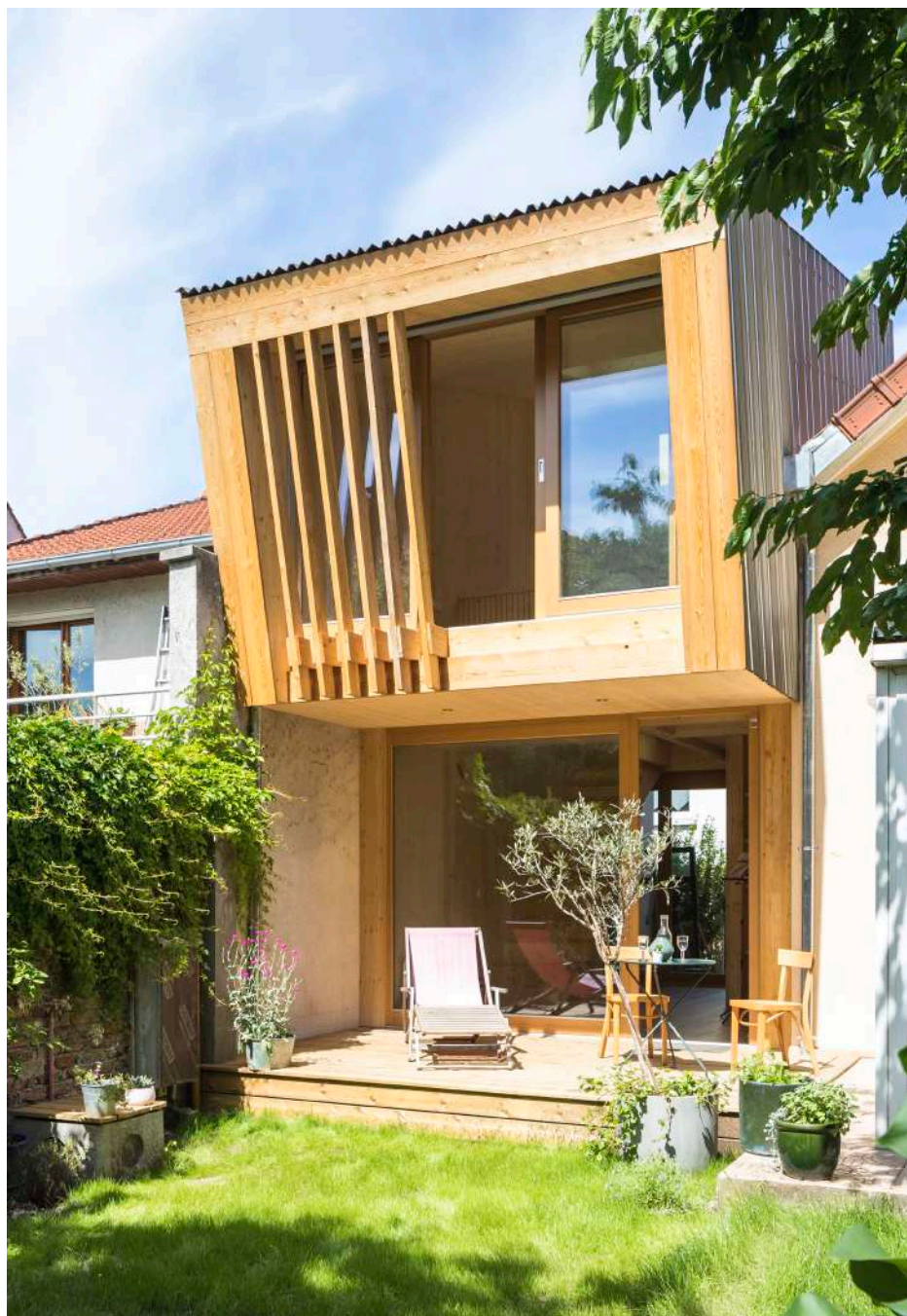
Façade Sud depuis le jardin
